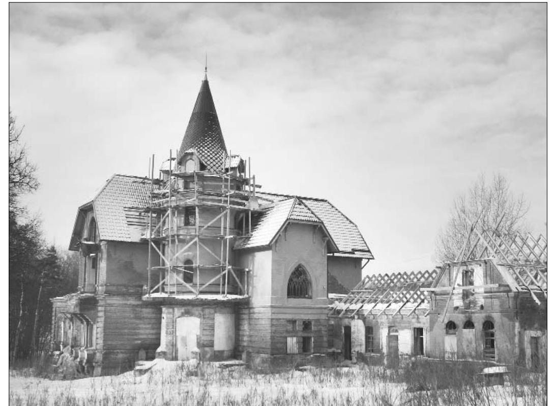
Недореставрированный особняк помещика Муханова
